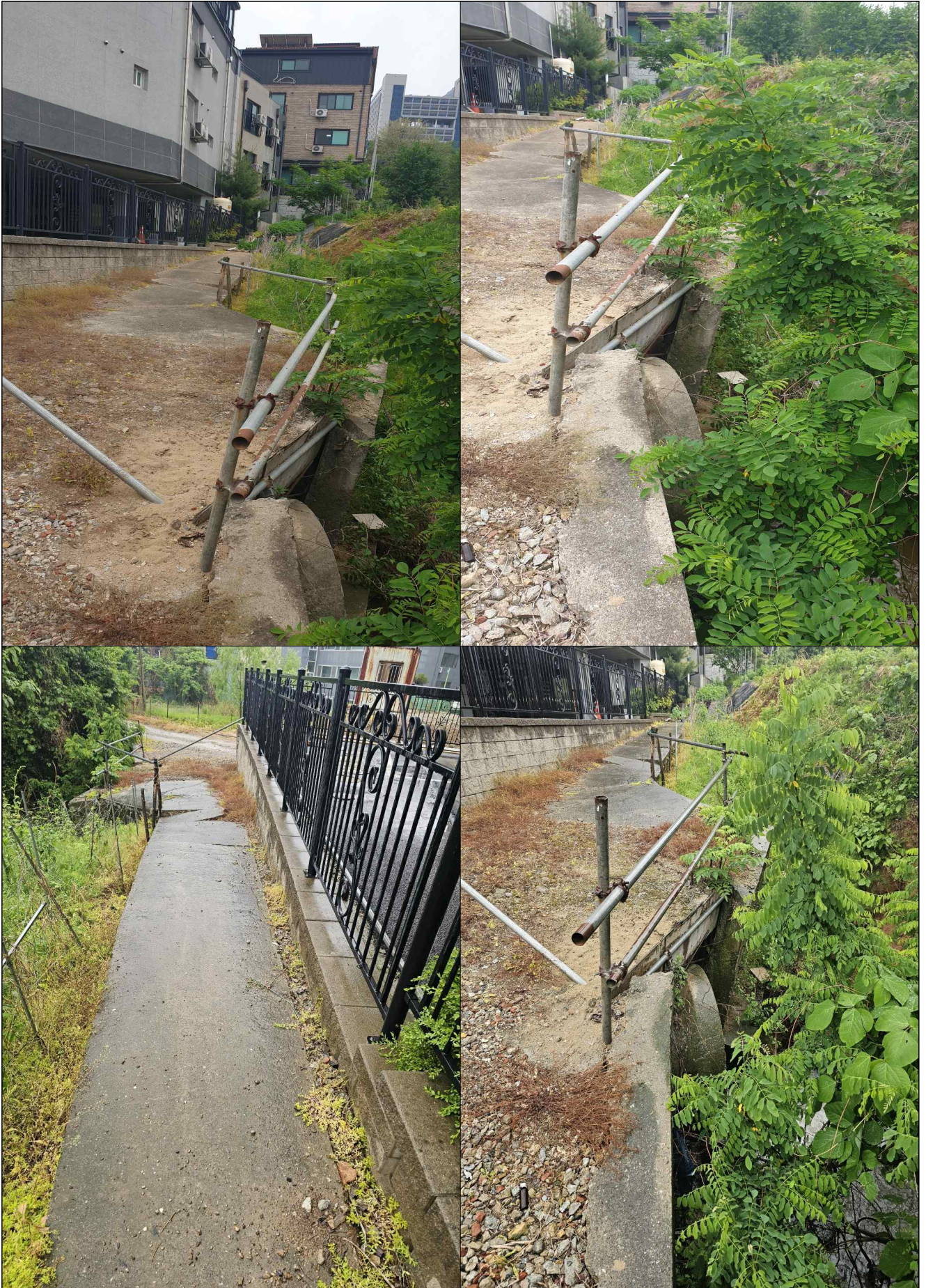
3) 현장 사진 2 (2026. 05. 19. 촬영)
