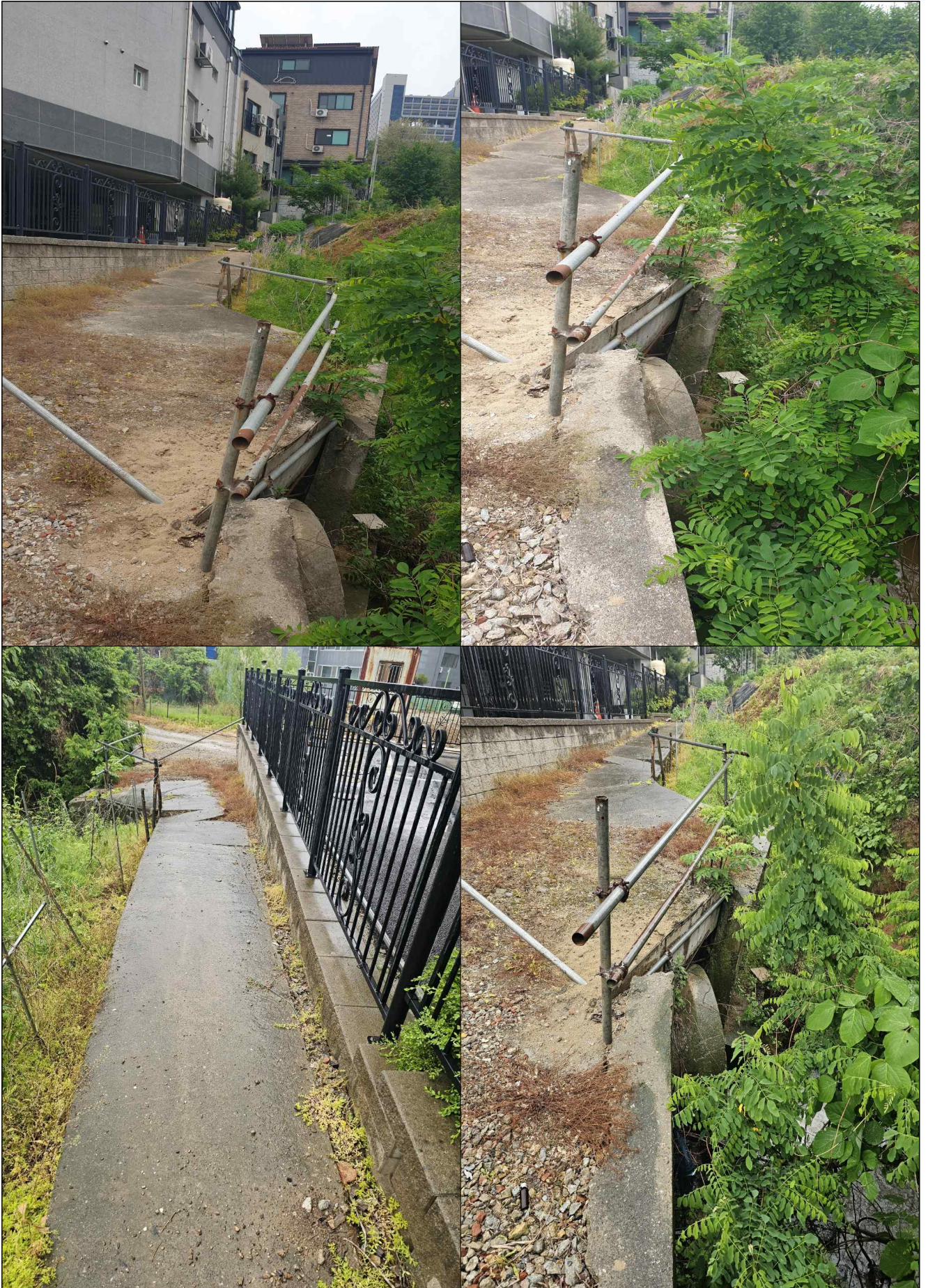
3) 현장 사진 2 (2026. 05. 19. 촬영)
