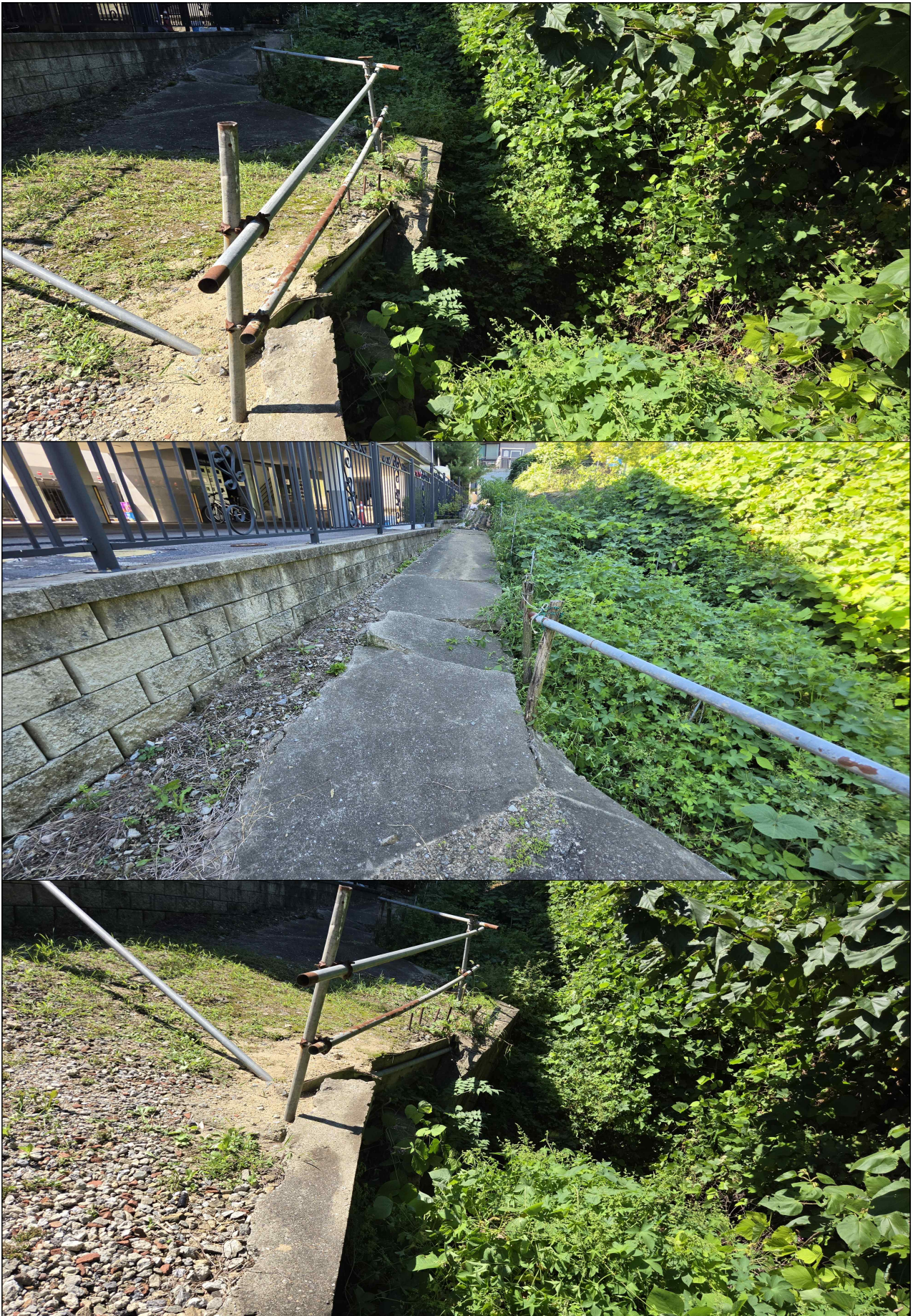
2) 현장 사진 1 ( 2026. 09. 04. 촬영 )
